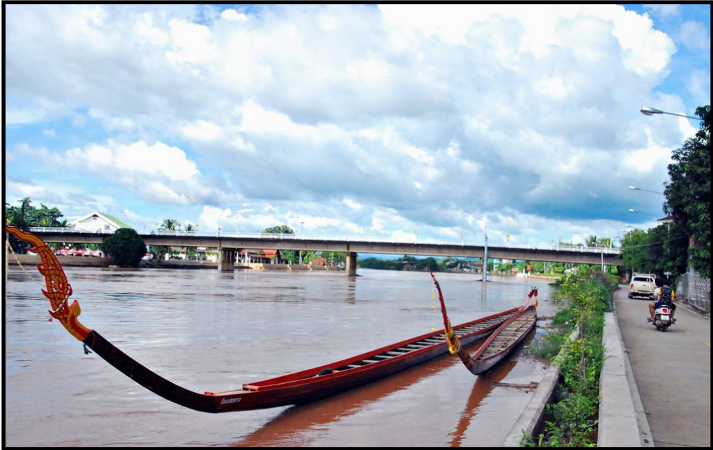
ทางเดินเลียบริมพั้งกันน้ำ ฝั่งอำเภอภูเพียง ช่วงบ้านแสงดาวขึ้นไปยังสะพานพัฒนาภาคเหนือ เมื่อเปรียบเทียบถือว่าน้ำอยู่ในระดับเดียวกับถนน
