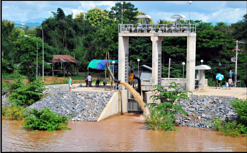
ประตูระบายน้ำบ้านศรีบุญเรือง ฝั่งอำเภอภูเพียง จังหวัดเร่งระบายน้ำที่เอ่อล้นเข้าไปจากด้านในออกสู่แม่น้ำน่าน
